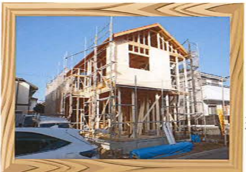
南楠の里町・M様邸 1月23日上棟
